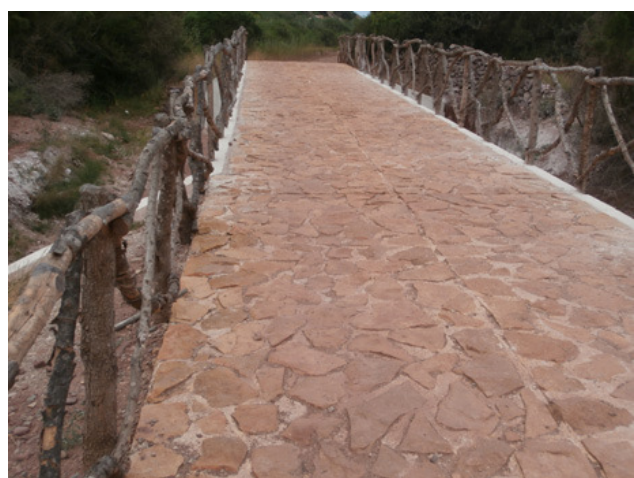
Assises en béton : 4m de large, au moins 1,5m de profondeur, très beau parement, l'ancienne piste détruite est interdite d'accès ...
