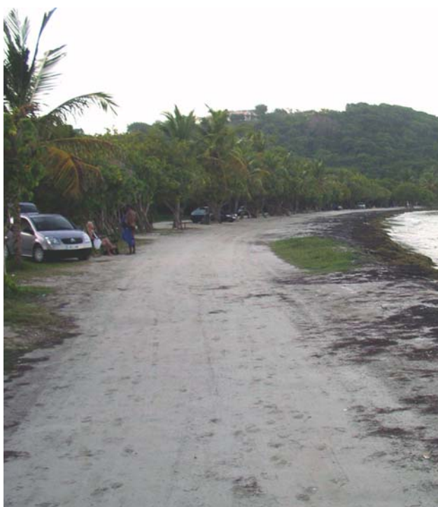
Saline Anse Canot, tassement du sol et dégradation de la végétation (Photo ONF Guadeloupe)
