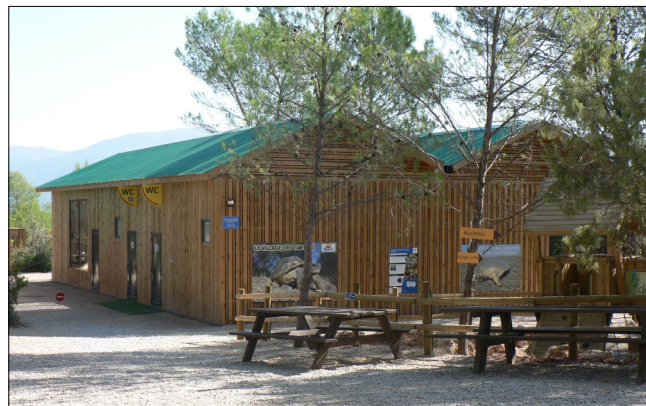
Le bâtiment de service et les sanitaires
